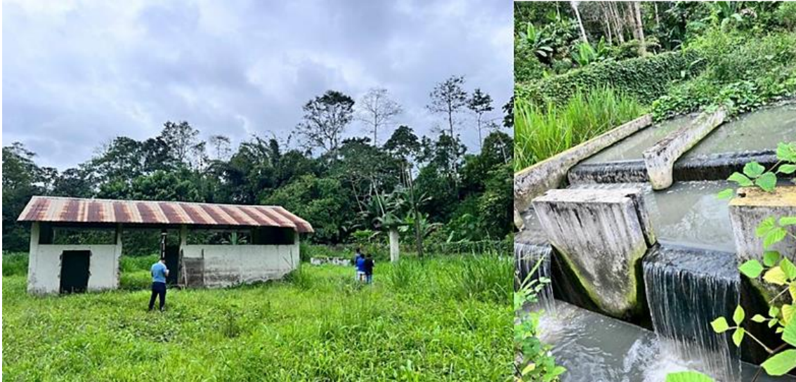
Imagen 13: Planta de tratamiento de aguas en el Cantón Puerto Quito.
