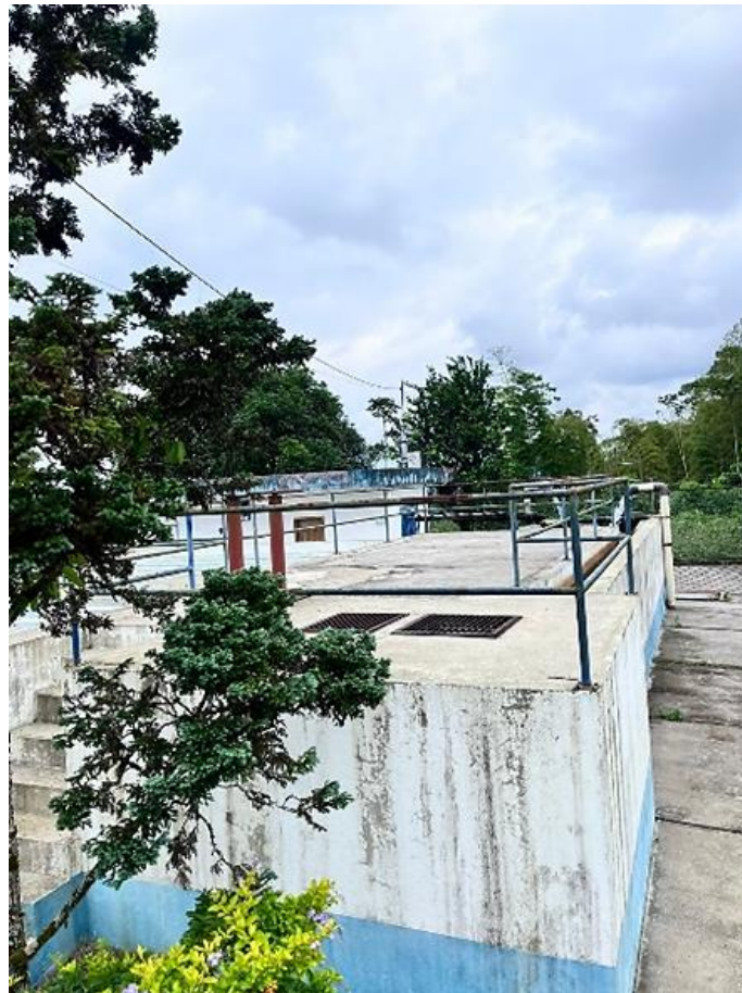
Imagen 21: Planta de Agua Potable
